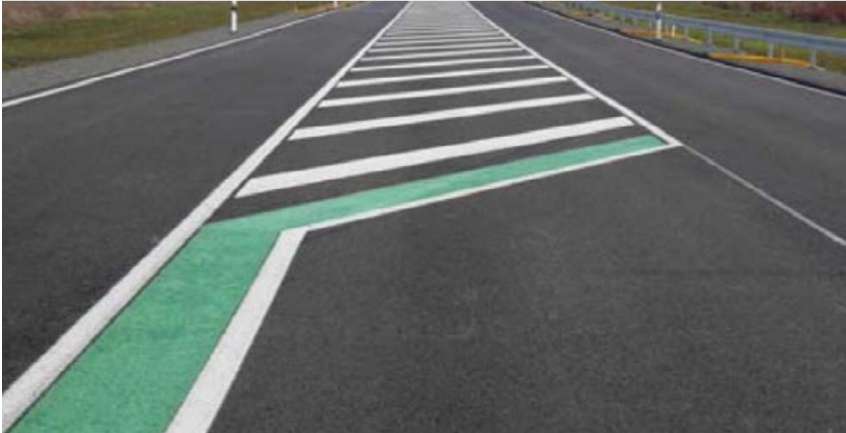
Obrázek 39 – Detail ukončení zeleného dělicího pásu, Německo
