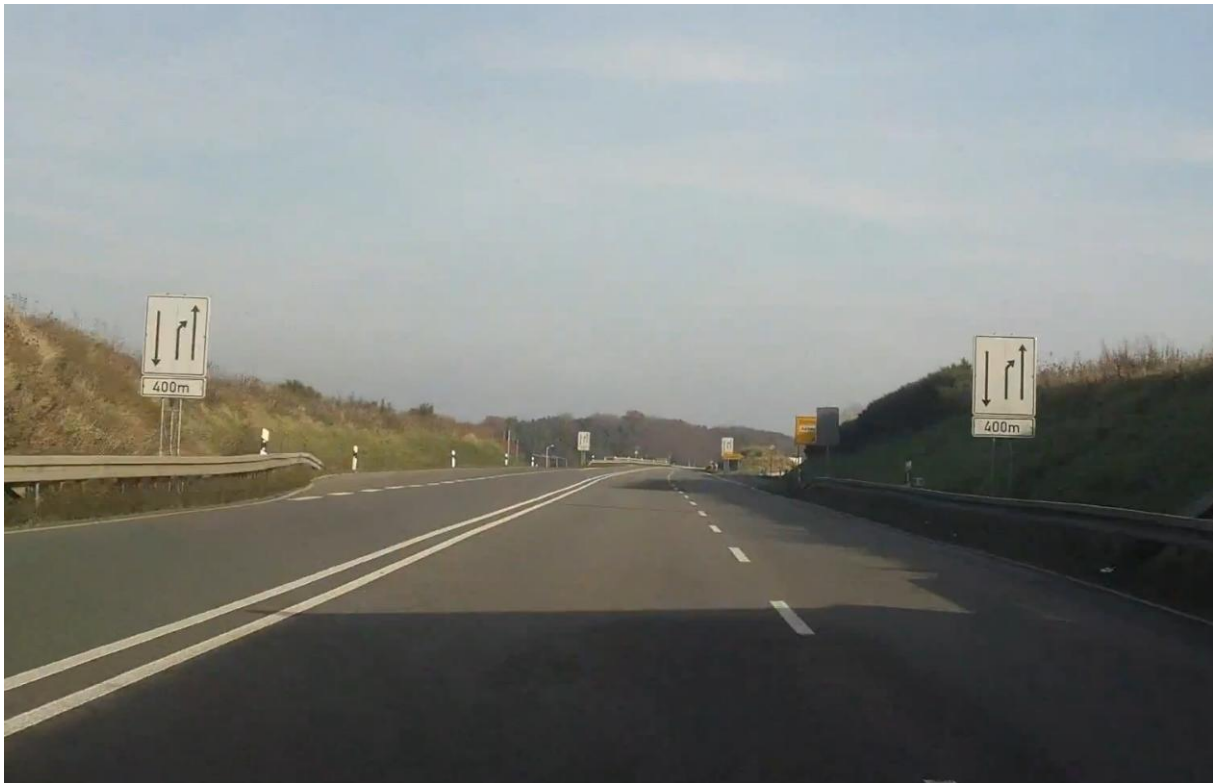
Obrázek 60 - Německo, návěst před kritickým přechodovým úsekem
