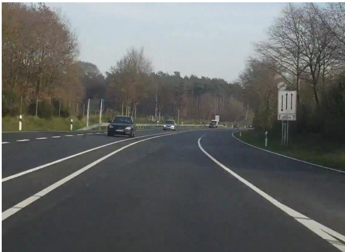
Obrázek 64 - Německo, připojovací jízdní pruh mimoúrovňové křižovatky (náhrada nekritického přechodového úseku)
