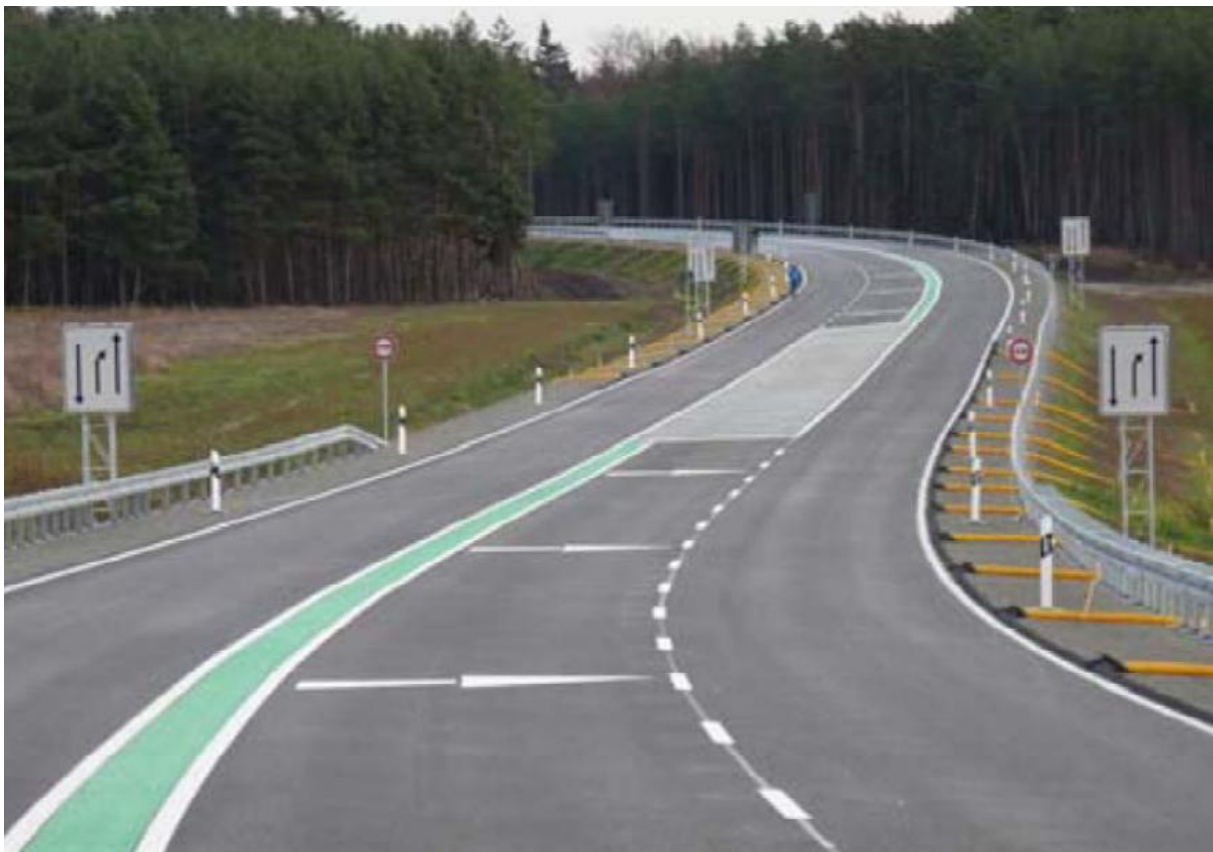
Obrázek 38 – Realizace nového uspořádání 2+1, Německo
